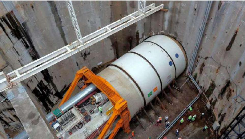
Pesando duas toneladas e com um diâmetro de mais de 10 metros, as tuneladoras atravessam mais de 15 quilômetros do subsolo da cidade
