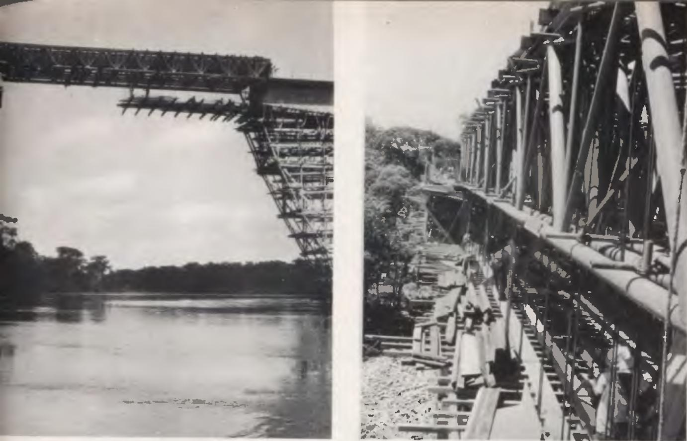
A construtora lançou sobre o vão central dezesseis treliças metálicas, que sustentaram o peso da "gerber".
