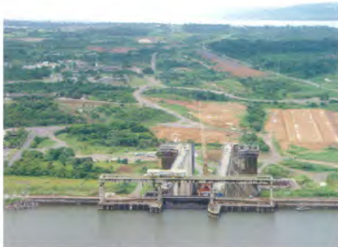
Tucuruí: finalizada a eclusa em 2010, carga atingirá 5 milhões de t
