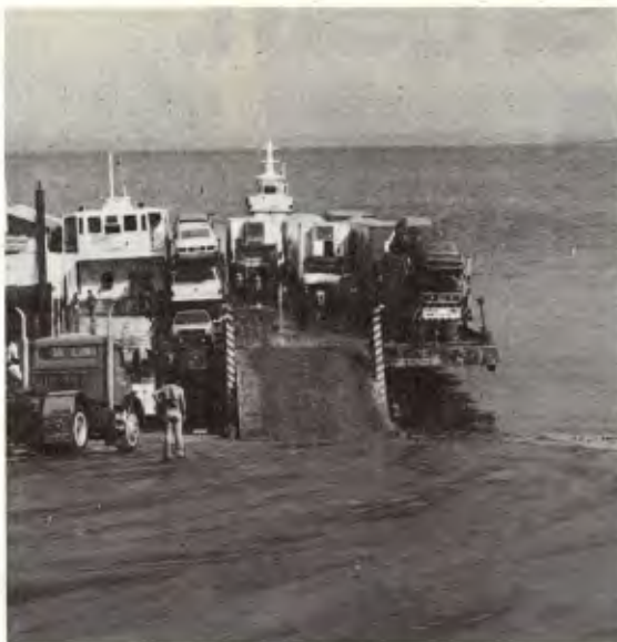
Falta de terminais adequados prejudica operação
