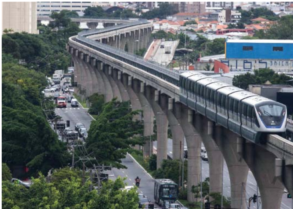
Monotrilho da Linha 15 – Prata (Vila Prudente-Hospital Cidade Tiradentes), em São Paulo, teve suas obras iniciadas em 2009 com entrega prevista para 2019
