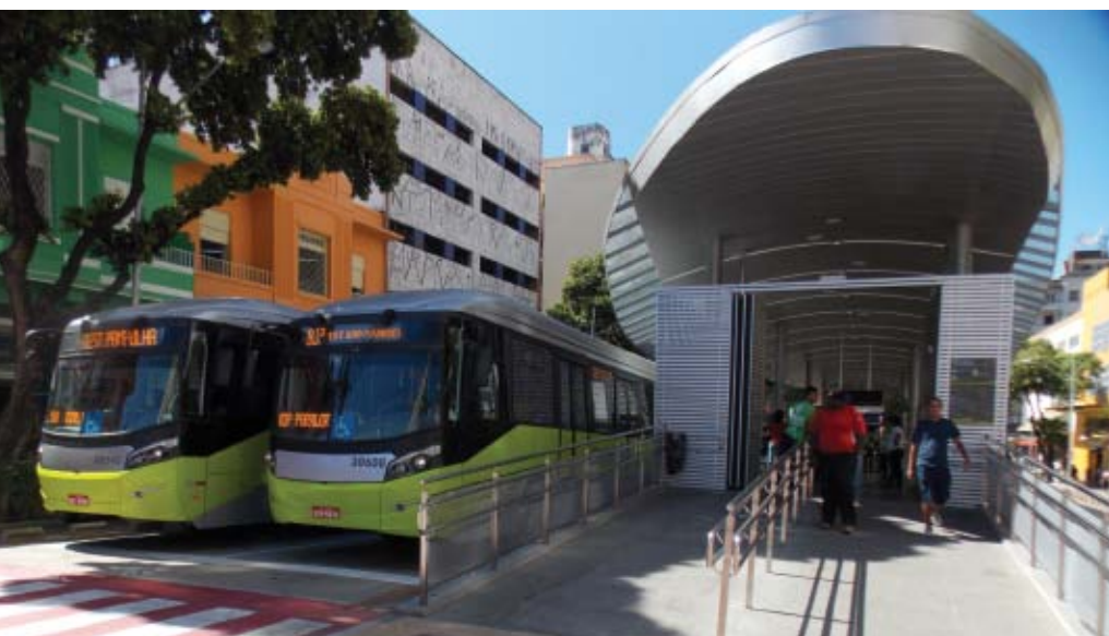
BRT de Belo Horizonte, denominado Move, iniciou atividades em março de 2014. Atualmente, há três corredores em operação, totalizando 23,1 quilômetros de extensão
