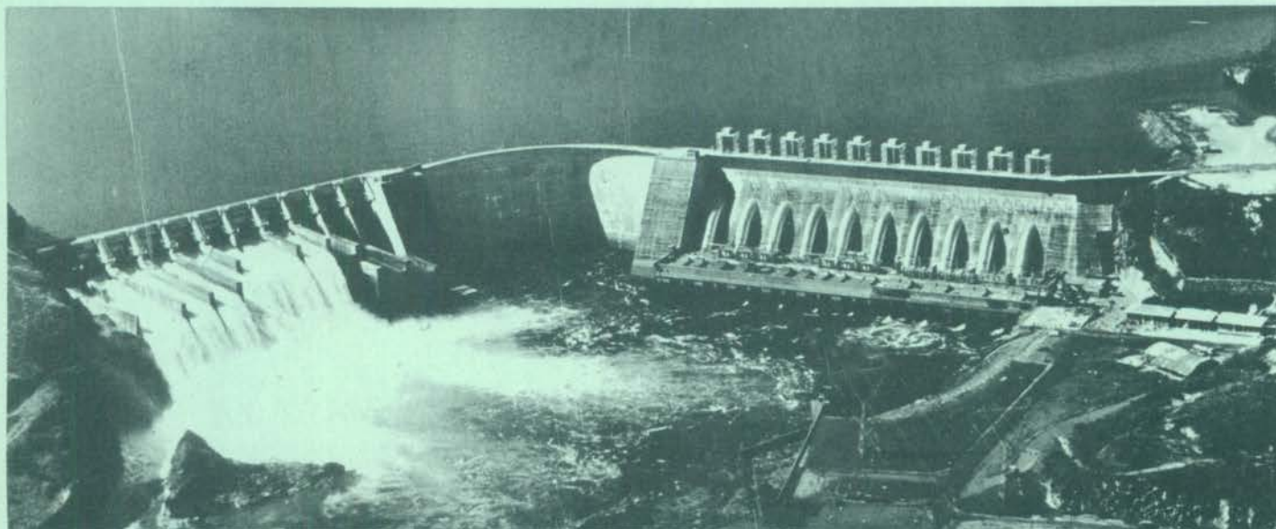
Uma das grandes usinas elétricas do Brasil, a Usina de Foz de Iguaçu, da Cia. Paulista de Força e Luz, Subsidiária da ELETROBRÁS, agora ampliada para 475.000 kw.
