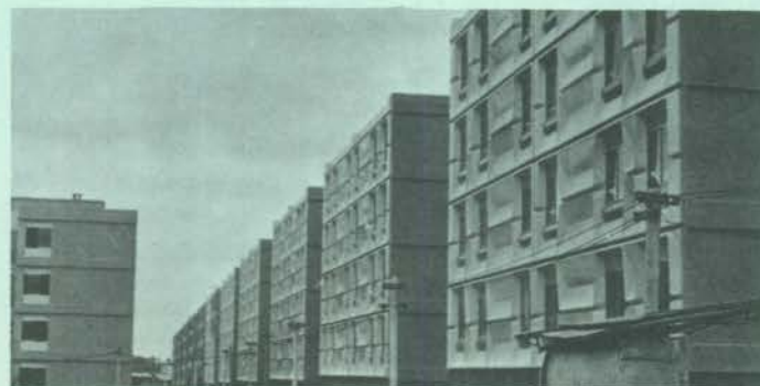
A construção em blocos pré-fabricados reduz prazos e custos.
