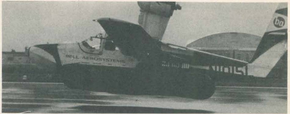
O colchão de ar aprovou no teste, em lugar do trem de pouso convencional.
