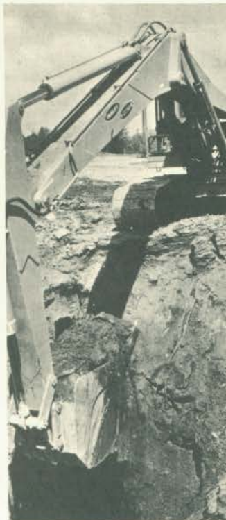
Escavadeira H-2250-B, de 45 t.
