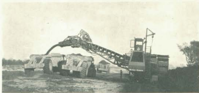
Escavadeira contínua, com caçamba de rodas e correia.
