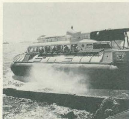
até 38 passageiros a uma velocidade máxima de 50 nós (92 km/h). Tem um motor para seu sistema integrado de sustentação e propulsão, e ultrapassa obstáculos até 1,5 m de altura. Custa US\$ 350 000. Com instrumental de navegação e radar opera à noite ou em condições de pouca visibilidade. A Tabela dá as principais características do modelo SR-N6.
