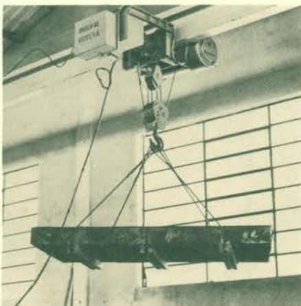
Talhas elétricas levantam até 20t
