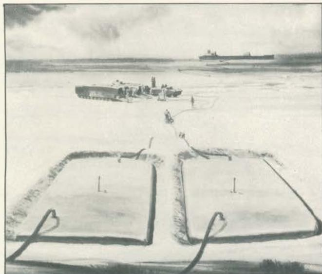
**TANQUES DE BORRACHA** — Com capacidade para 75 mil litros, estes tanques de borracha foram construídos pela Firestone para armazenar combustíveis destinados a postos de abastecimento de difícil acesso. Instalados nas proximidades de praias, são abastecidos por navios-tanque e o combustível é bombeado para os pontos estratégicos de abastecimento.
