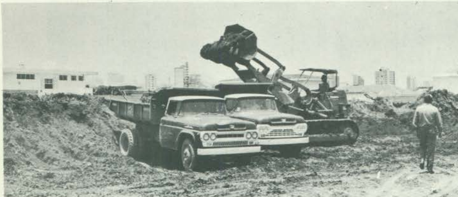
Trabalho conjunto de trator escavo-carregador e caminhões basculantes.
