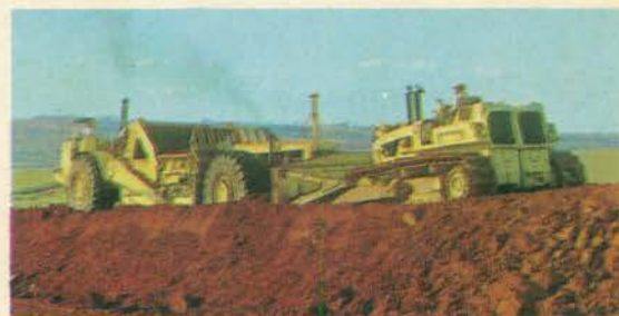
OPERAÇÃO DE "PUSHER" DO TRATOR EUCLID 82-80 NAS OBRAS DA HIDROELÉTRICA DE IBITINGA - SP.
