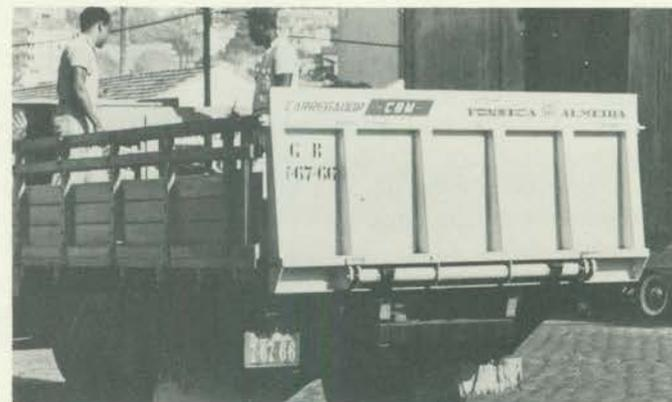
O autocarregador é acionado pelo próprio veículo. Eleva 2,5t e elimina a necessidade de outros equipamentos. É fabricado em sete tipos diferentes de plataforma.
