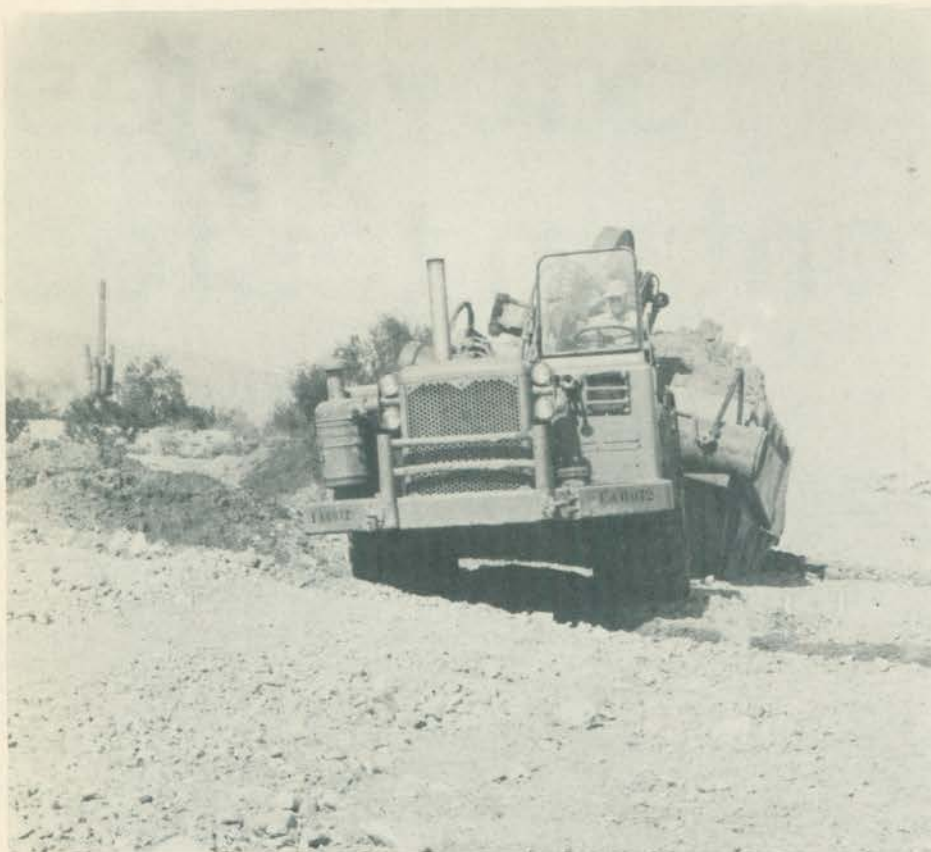
Estradas contendo valetas exigem esforços bastante severos dos moto-scrapers.
