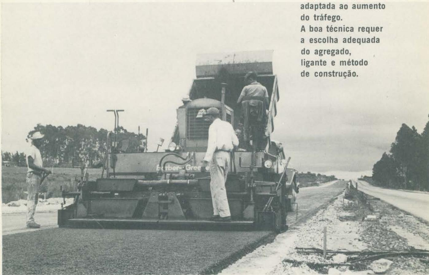
Há muitos fatores a serem considerados num projeto de estrada: previsão do tráfego, condições da base, drenagem adequada, condições climáticas, fundos e equipamentos disponíveis. A chave da boa construção rodoviária é a escolha inteligente da pavimentação em função das condições existentes. São seus requisitos: suportar as cargas produzidas pelo tráfego; proteger o leito da estrada contra água; diminuir perdas dos materiais superficiais; obter textura superfi-
