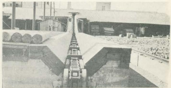
Transportador para toros de madeira, instalado na Lutchet.
