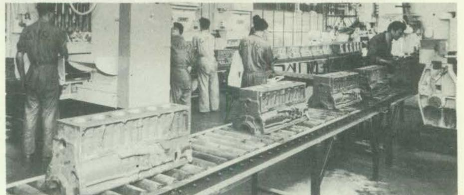
**TRANSPORTADOR PESADO** — Fabricados no Brasil transportadores de rolêtes livres para transporte de peças pesadas de produção em linha. Este equipamento facilita a manipulação das cargas, pois para sua movimentação sobre o transportador, é suficiente uma aplicação de força correspondente a apenas três por cento do peso do material. **Serviço de Consulta n.º 4**.
