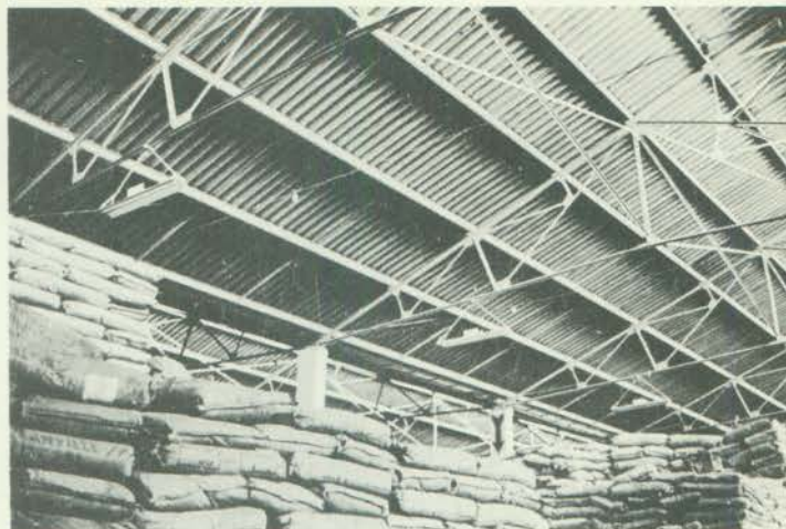
As pilhas terminam um metro abaixo dos sprinklers.
