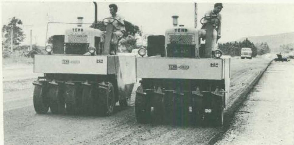
Estes rolos lisos de pneus são utilizados no acabamento das camadas do solo.
