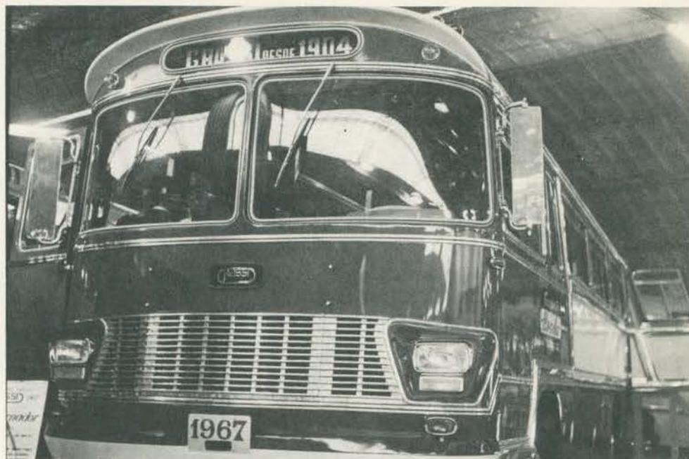
Carroçaria montada sobre chassi, fabricada de alumínio, para ônibus rodoviário.
