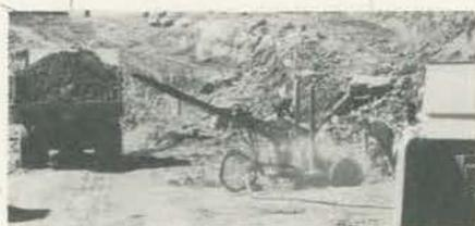
**Fonte de ar comprimido** — Constituída por compressores de variadas capacidades, que fornecem o ar para os equipamentos de perfuração. Para trabalhos comuns de cor-
