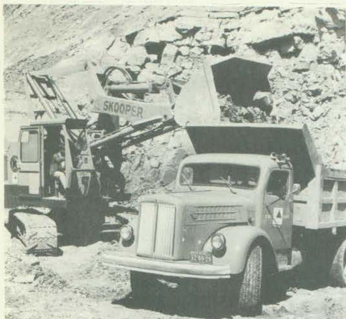
Pá hidráulica de 0,75 m<sup>3</sup> carregando basculante: 200 m<sup>3</sup>/h.
