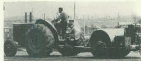
Os equipamentos de compactação são constituídos basicamente por rolos de várias capacidades destinados a adensar as diversas camadas da base, ou proporcionar uma infra-estrutura resistente ao revestimento superior. Tanto o rôlo pé-de-carneiro como o liso são lastreados com água em seu interior, para atingir o peso ideal de compactação. Há também os modelos
