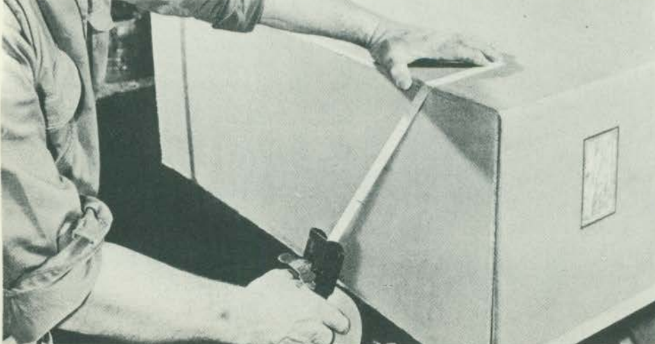
As caixas de madeira arqueadas com fitas de aço são, praticamente, invioláveis.
