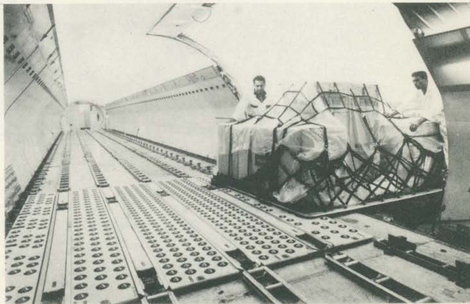
Os pallets passam do elevador para o piso do avião dotado de rodízios.
