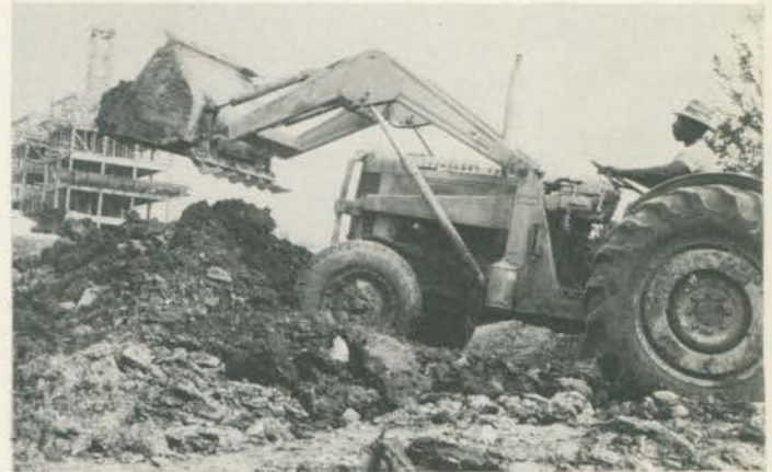
O carregador dianteiro recolhe e transporta materiais.
