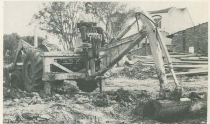
A retro-escavadeira abre valetas em lugares difíceis.
