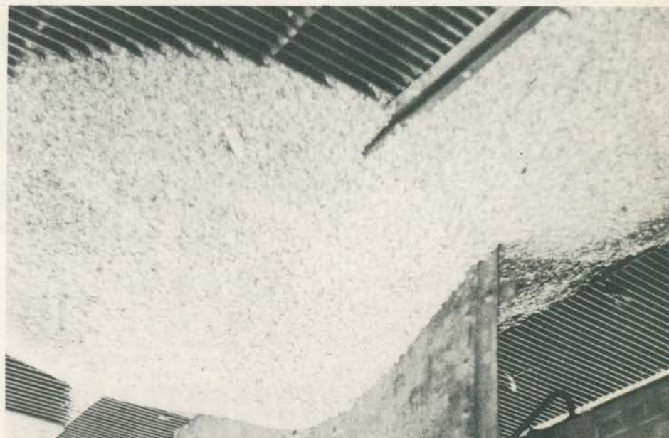
Um sistema adequado de alimentação elimina as perdas e facilita o serviço.
