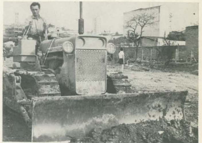
O trator MF-244 espalha materiais e remove obstáculos.
