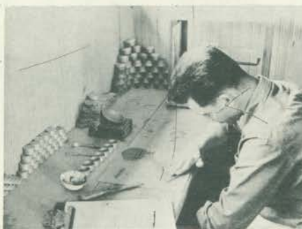
Ensaio de plasticidade: o rolinho obtido fornece a característica do solo.
