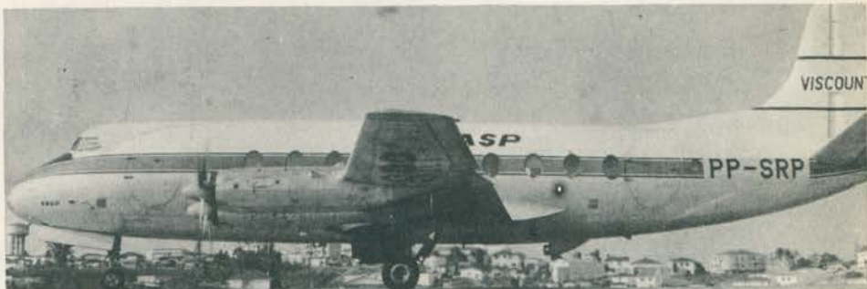
Os motores turboélice dos Viscounts são revisados cada 3.200 horas de voo.
