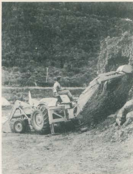
É possível equipar um só trator com retro-escavadeira e carregador frontal.
