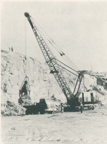
Blocos de pedra são facilmente erguidos por uma escavadeira de mandíbulas.
