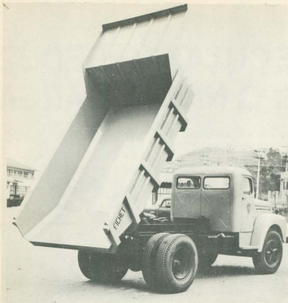
Basculante com caçamba reforçada, especial para o transporte de minérios.
