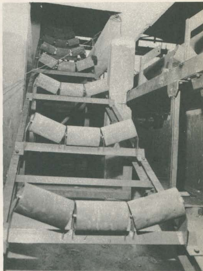
Fase de montagem do transportador de correia da Mogiana com rolêes LINKBELT-PIRATININGA revestidos de borracha.
