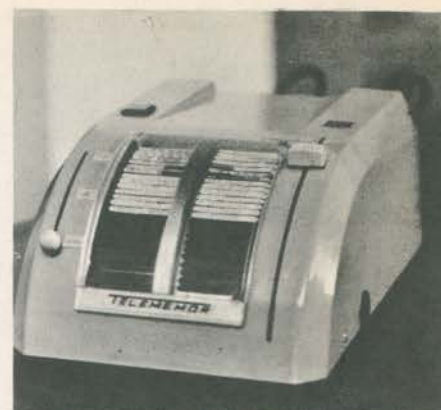
O Telememor elimina a necessidade de discagem, na ligação de telefones.
