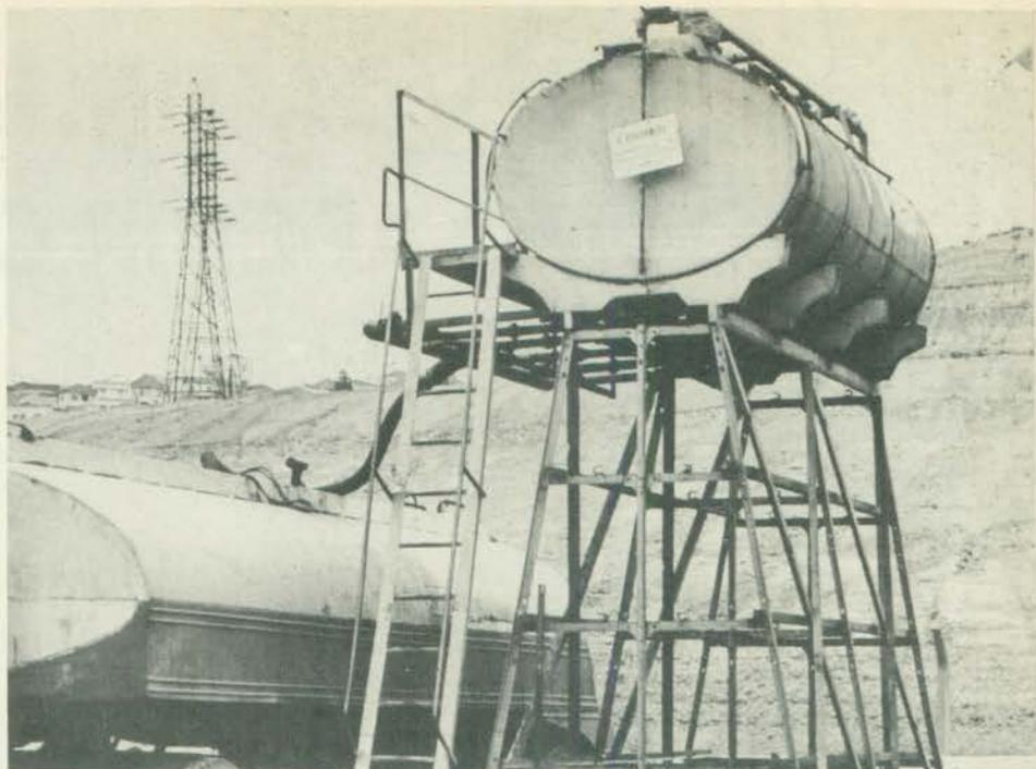
Recipiente-padrão utilizado para aferir a capacidade do caminhão-tanque.
