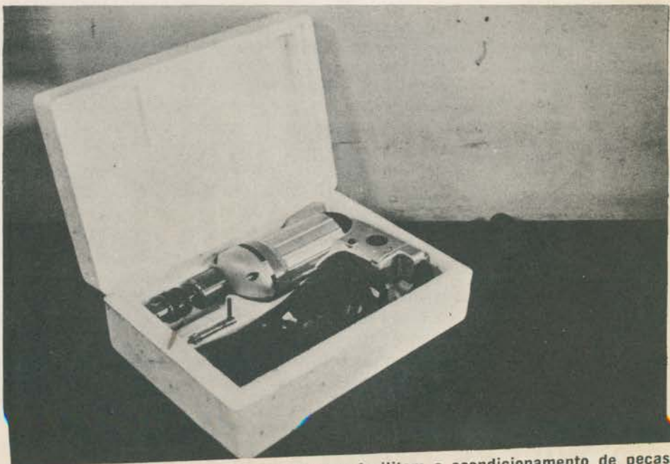
Embalagens confeccionadas com estiropor facilitam o acondicionamento de peças.
