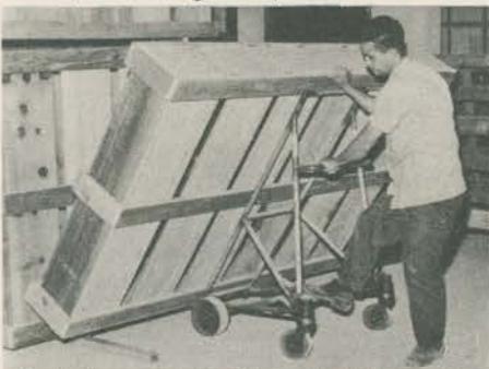
Carrinhos com rodízios giratórios e braços facilitam a movimentação interna.
