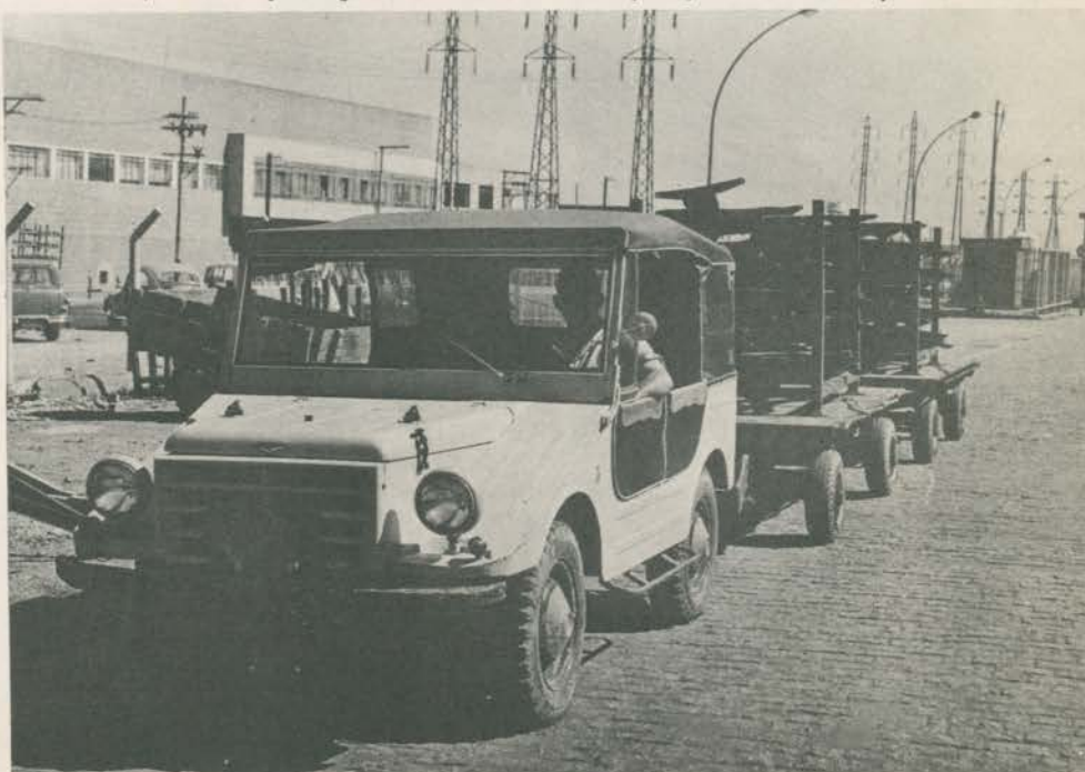
Utilitários com tração nas quatro rodas tracionam trens leves nas indústrias.
