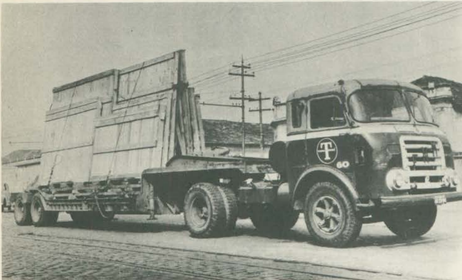
As chapas de vidro de grandes dimensões são transportadas em semi-reboques.
