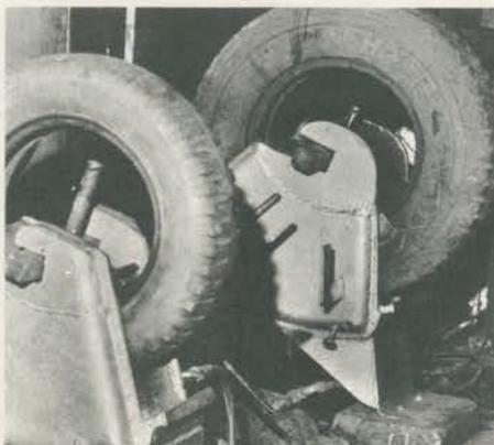
Conforme as dimensões do conserto, a vulcanização leva de 1 a 3 horas.
