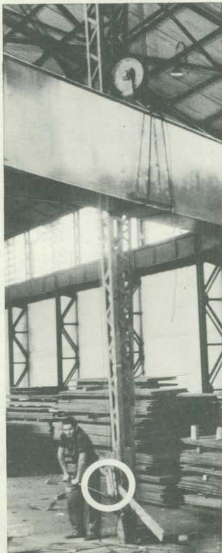
Com o tirfor e uma torre central, montam-se facilmente pontes rolantes.
