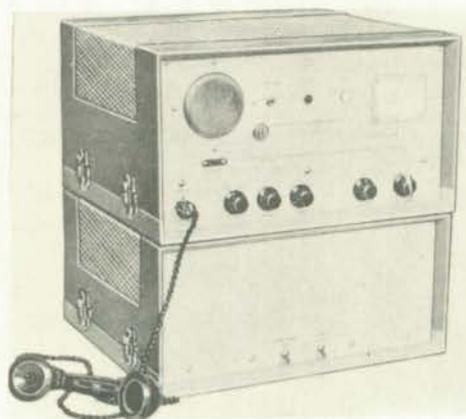
**RADIOTELEFONE** — Transmissores que operam nas bandas de VHF e UHF, e em SSB, permitem contato rápido e eficiente entre filiais e matriz de uma mesma organização. São fornecidos com até quatro canais pré-sintonizados e alguns modelos possuem controle remoto e dispositivo que permite seu acoplamento à rede telefônica. **Serviço de Consulta n.º 2.**
