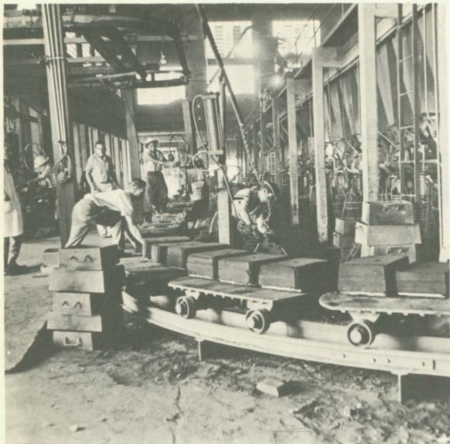
Na Vigorelli um transportador de vagonetas conduz moldes para o vazamento.
