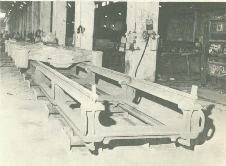
Trilhos sobre rolêtes transportam peças fundidas para a retirada de rebarbas.
