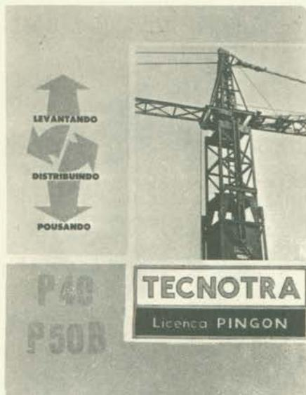
**GUINDASTES** — Tecnotransportes S.A. apresenta catálogo dos guindastes "Tecnotra" — licença "Pingon", de sua fabricação. As unidades oferecidas são montadas sobre trilhos, equipadas com caixa portátil de botões para controle remoto e limitador de momento, que impede o levantamento de cargas superiores à autorizada. As lanças atingem 25 e 30 metros, nos tipos P 40 e P 50 B. **Serviço de Consulta n.º 11.**
