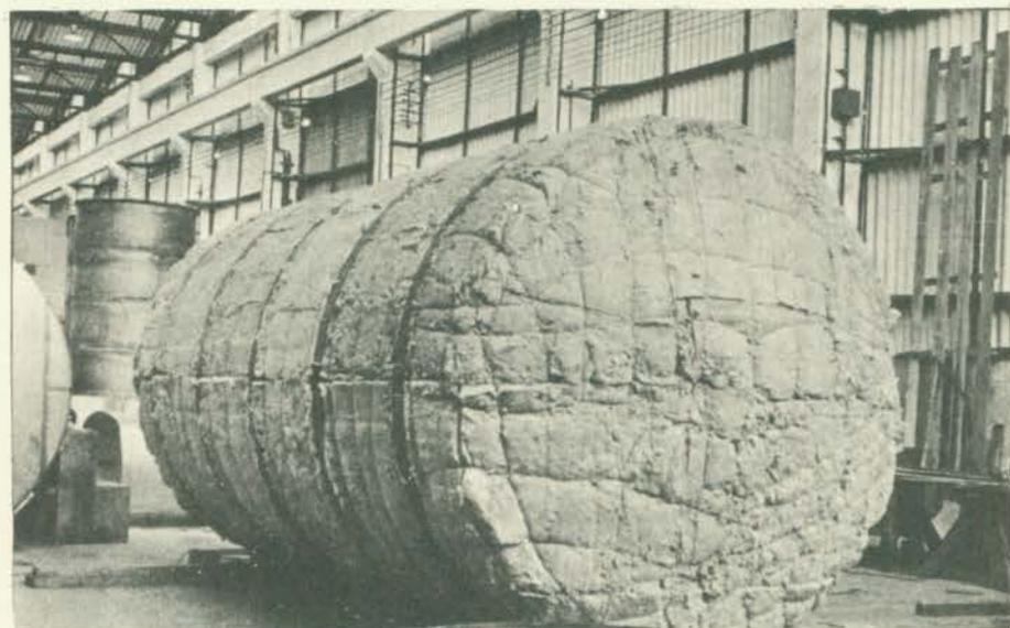
Para leite e asfalto, todos os reservatórios recebem revestimento isotérmico.
