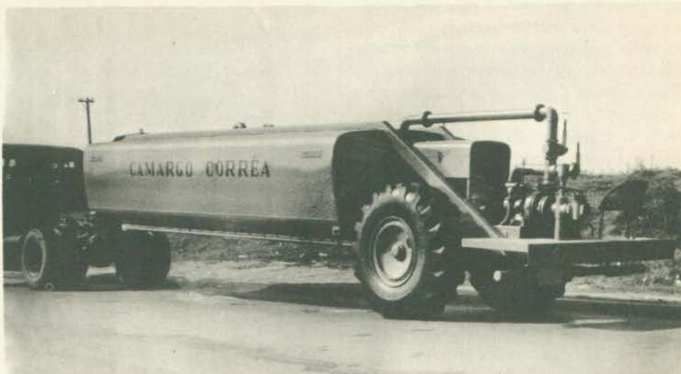
O semi-reboque tanque, de 18 mil litros, auxilia em trabalhos de terraplenagem.
