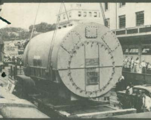
Descarga para a gôndola ferroviária
