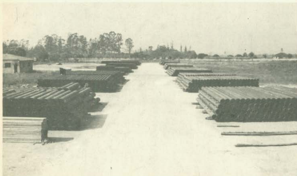
Na estação inicial de Campos Elísios, foram armazenados 30.500 tubos. Com 12m de comprimento e 18" de diâmetro, sua espessura varia de 5/16" a 1/2".
