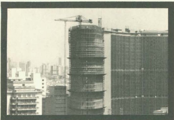
Guindaste ascensional TORQUE SCHWING para construções (Foto Edifício Itália)
