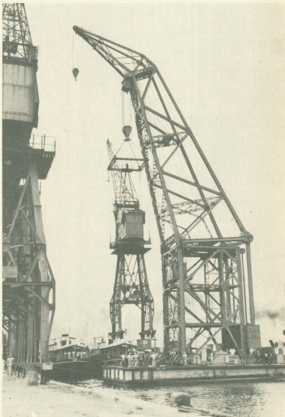
Demonstrando grande potência e maneabilidade, a cábrea Sansão, da Companhia Docas de Santos, transporta um guindaste Stother L. Pitt de 72 toneladas.
