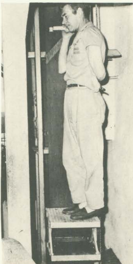
O "pater noster" consiste de uma correa com plataformas a ela fixadas.
