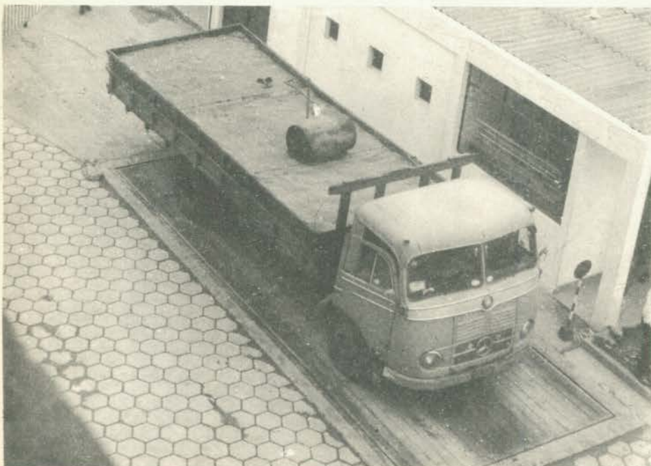
A balança eletrônica pode ser adaptada a instalações já existentes. O desconto da tara, durante as pesagens, é realizado automaticamente, sem nenhum problema.
