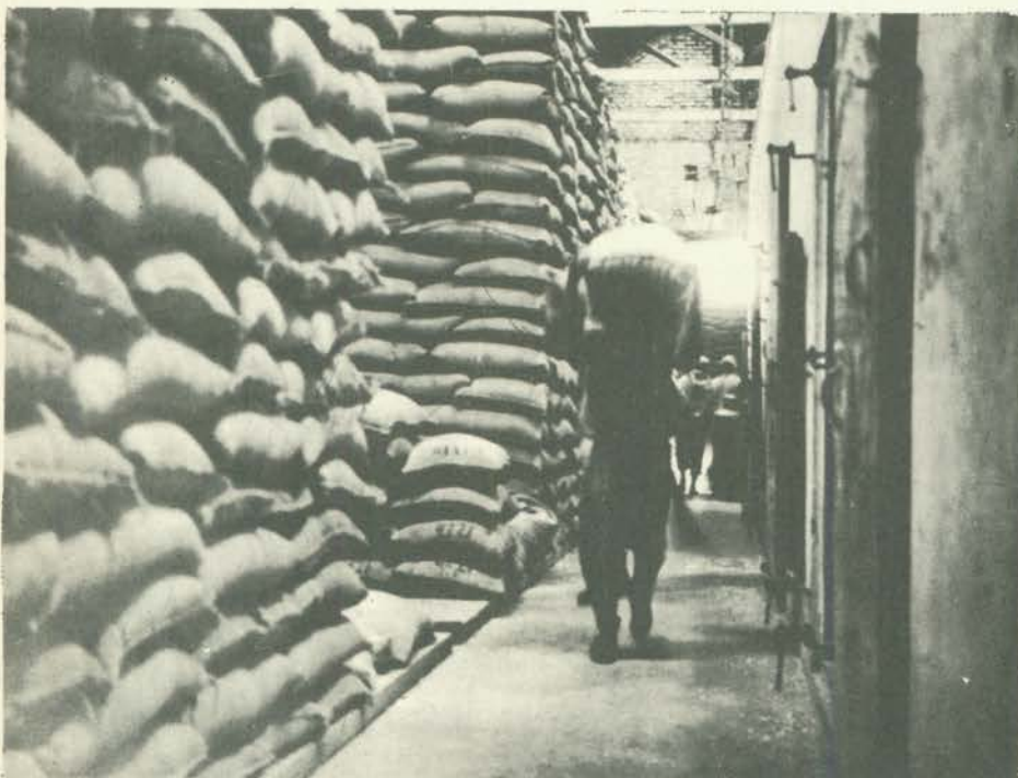
O carregamento manual ainda é o sistema mais utilizado nos armazéns. No corredor da foto vêem-se à direita portas das câmaras de expurgo, para sacos
