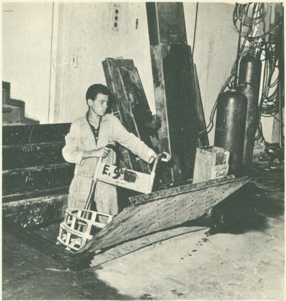
O elevador de alçapão é um equipamento utilizado especialmente na carga e descarga de garrafas, caixas, latas e pacotes, entre o pavimento térreo e o subsolo.
