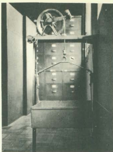
Um monta-cargas manual é o equipamento mais indicado para cargas leves.
