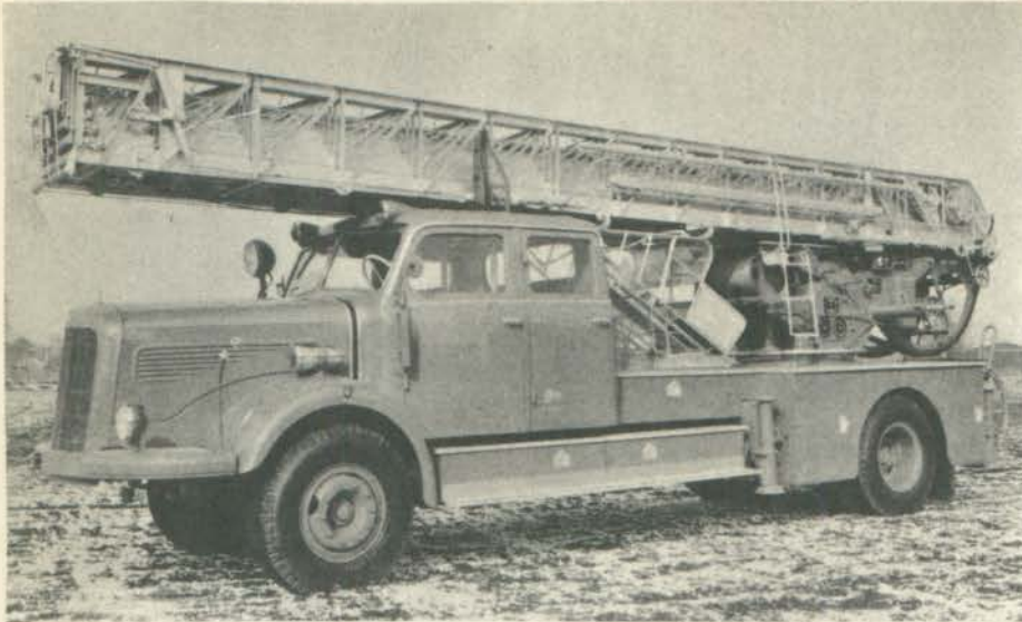
Entre os implementos adaptáveis a caminhões, destacam-se os destinados aos carros-bombeiro, principalmente escadas telescópicas, de longo alcance, tipo Metz.
