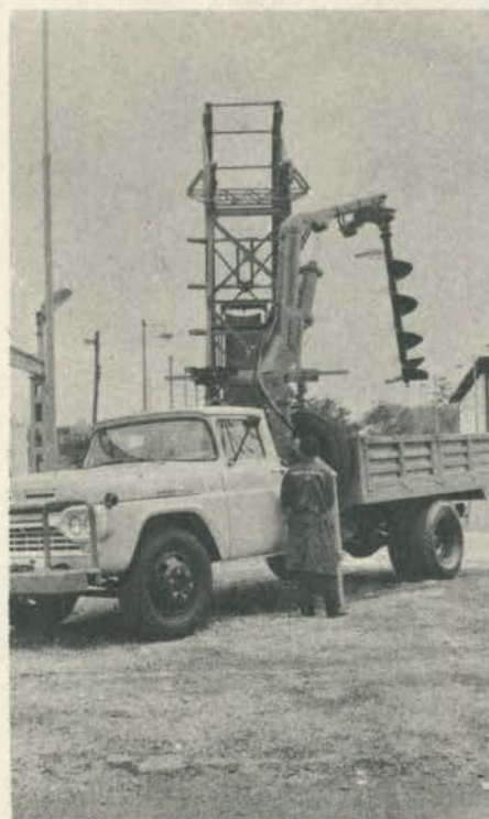
Para instalar postes e estacas, há, também, uma perfuratriz de solo.
