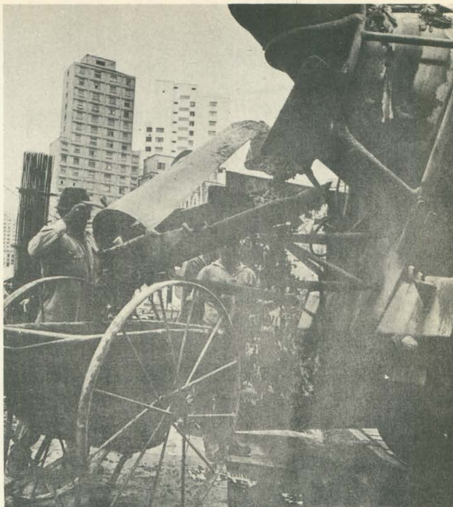
Destinada a misturar os componentes do concreto e conservá-lo em condições de utilização, a betoneira executa seu trabalho instalada sobre o próprio caminhão.
