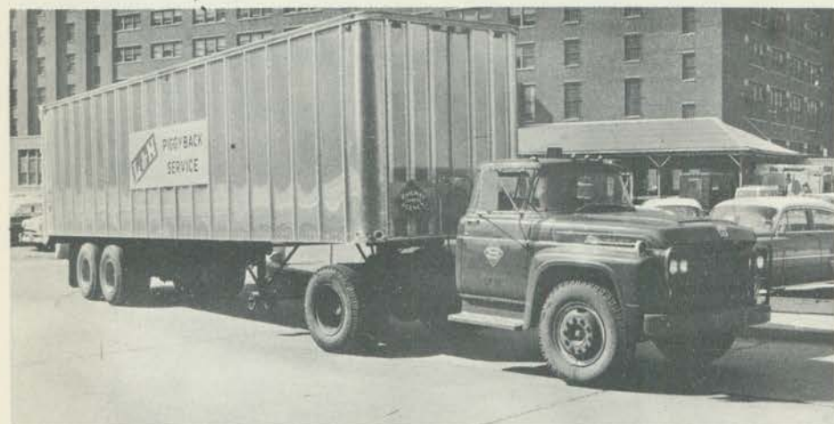
Fabricado em um semi-reboque, o furgão da L & N norte-americana é destacável de sua base para ser adaptado, depois, com facilidade, a um vagão ferroviário.
