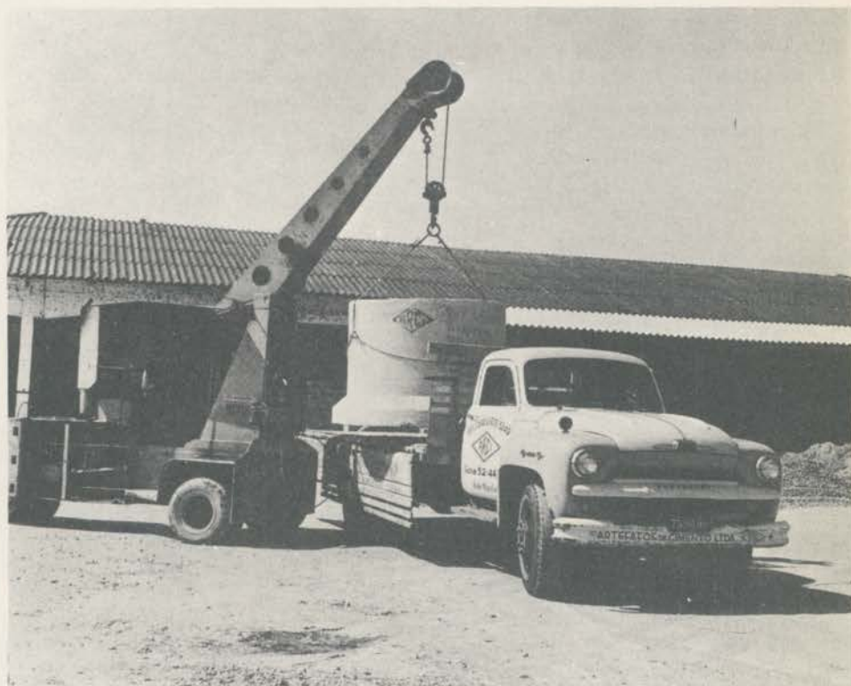
Um Karry Krane KD, da Hyster, levantando um tubo de concreto vibrado de 4 toneladas. Substitui o trabalho de 12 homens nesse serviço e reduz a mão-de-obra.
