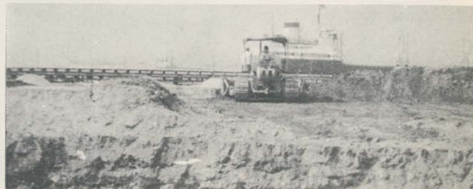
Obras de ampliação da área de estocagem de minério de ferro e prolongamento da linha de caminhamento do pórtico rolante — Parque de Minério e Carvão. ●
