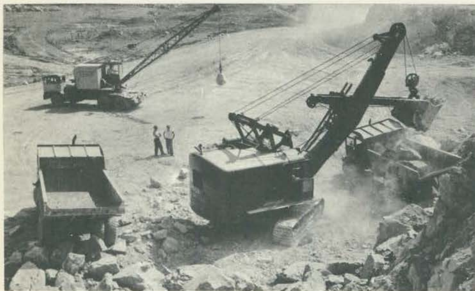
CONSTRUÇÃO DE AEROPORTO — Uma pá escavadeira carrega dois "dum-trucks". Ao fundo vê-se um guindaste móvel, instalado sobre o chassi de um caminhão.
