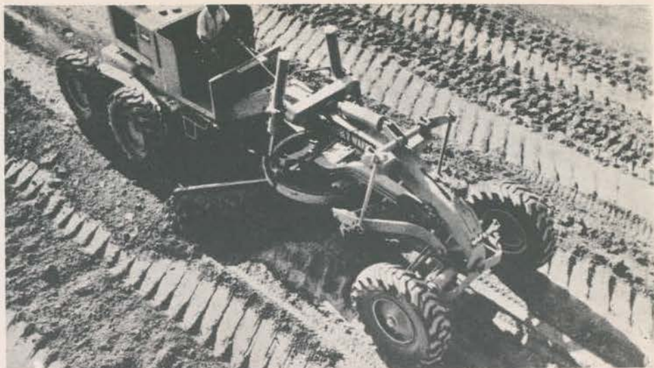
TRABALHO DE PLAINA — Observe-se pelos traços no solo que o terreno já foi percorrido pelos "moto-scrapers", dessa potente motoniveladora da "Huber-Warco".
