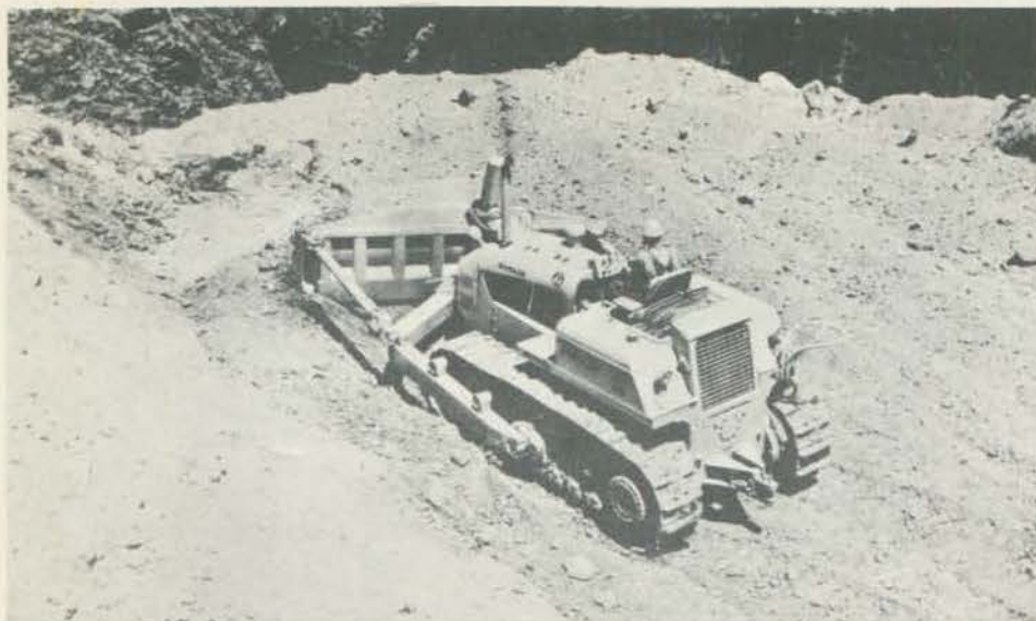
"ANGLE-DOZER" — O C-6, da Euclid, é um dos mais difundidos. Veja-se a angulação lateral da lâmina, muito útil em todos os trabalhos de cortes elevados.
