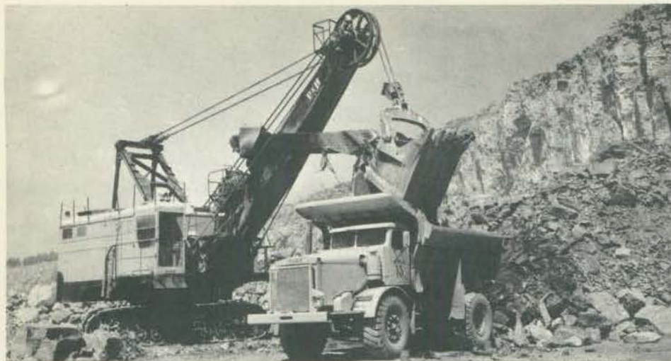
PA ESCAVADEIRA — Máquinas deste tipo já estão sendo fabricadas há algum tempo no Brasil pela Villares. O caminhão é importado e distribuído pela Expan.
