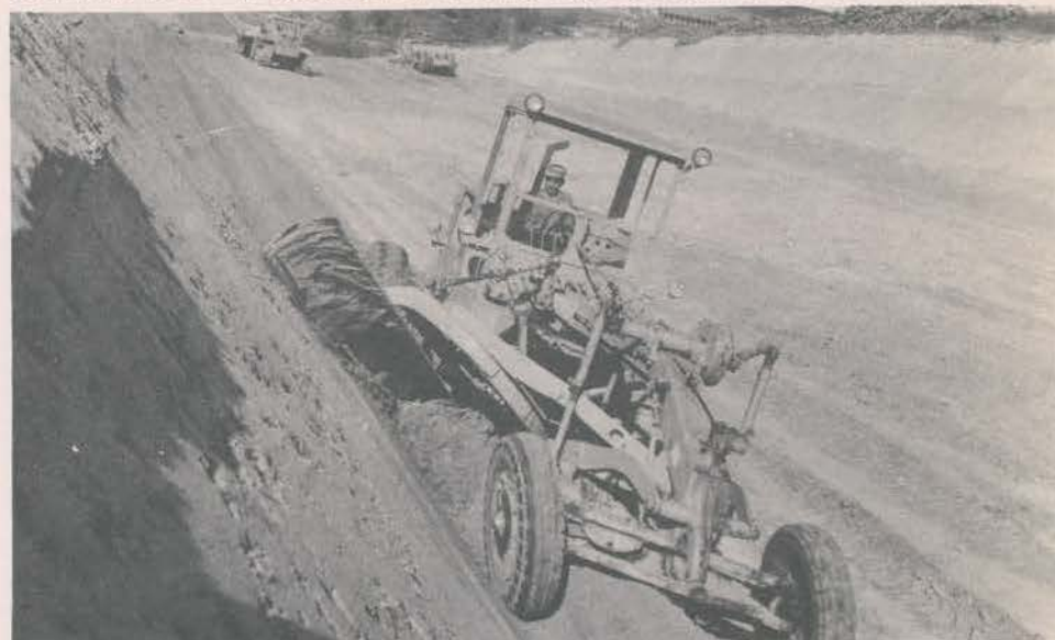
MOTONIVELADORA BARRANQUEANDO — As rodas dianteiras da máquina permanecem perpendiculares ao solo. Isto é importante para manter o alinhamento.
