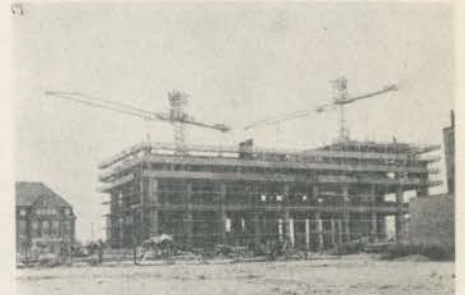
CONJUGAÇÃO — Dois ascensionais trabalhando juntos num único edifício.
