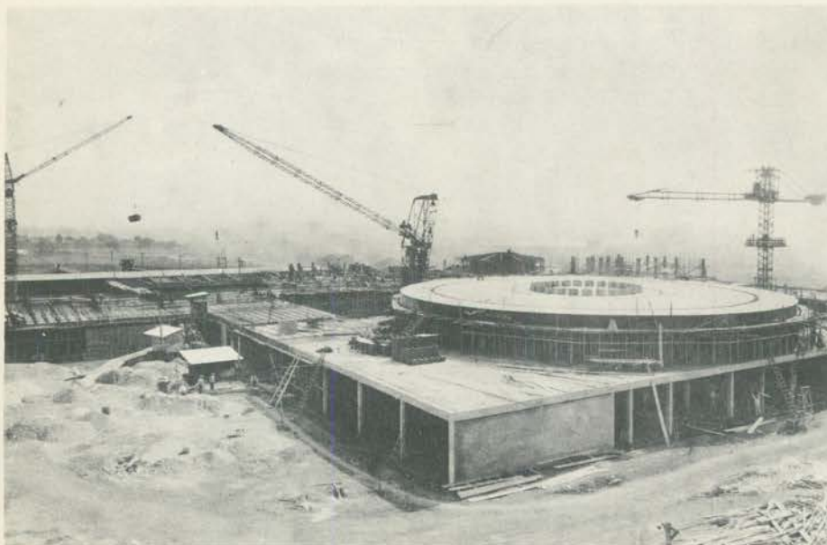
TRÊS NUMA OBRA — Isto aconteceu na construção do hospital do IAPI, em São Paulo. O resultado foi um ritmo de construção acelerado, com excelente rendimento.
