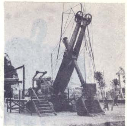
Pá escavadeira BR 125, da Clark
