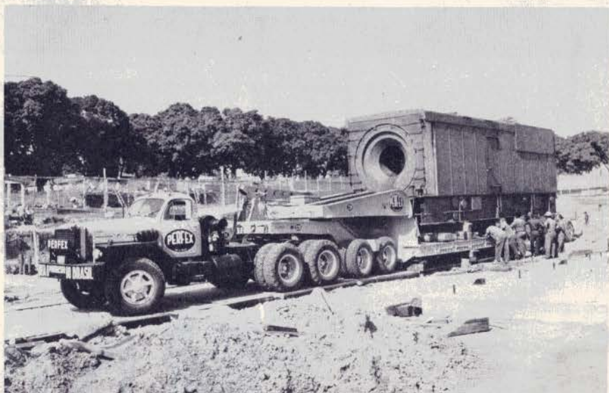
CONSTRUÇÃO — Vias de acesso foram construídas em diversos trechos, para darem passagens às cargas, cuja distribuição era de 15 toneladas por eixo.
