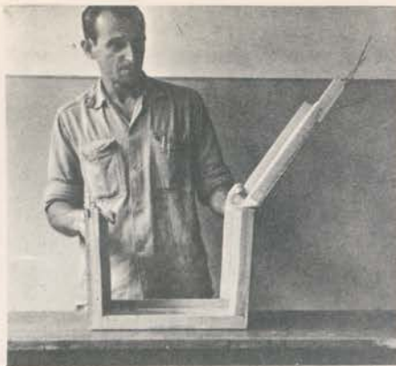
Figura 3: Fases da montagem de uma embalagem tipo "wire-bound".
