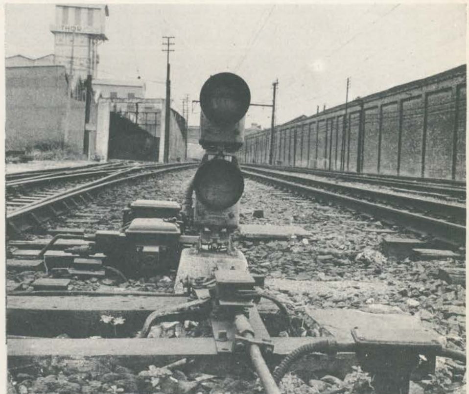
PEQUENO — Um farol anão, de dois sinais, colocado junto a um desvio. De aparência simples, dele muito depende o desenvolvimento e a segurança do tráfego.
