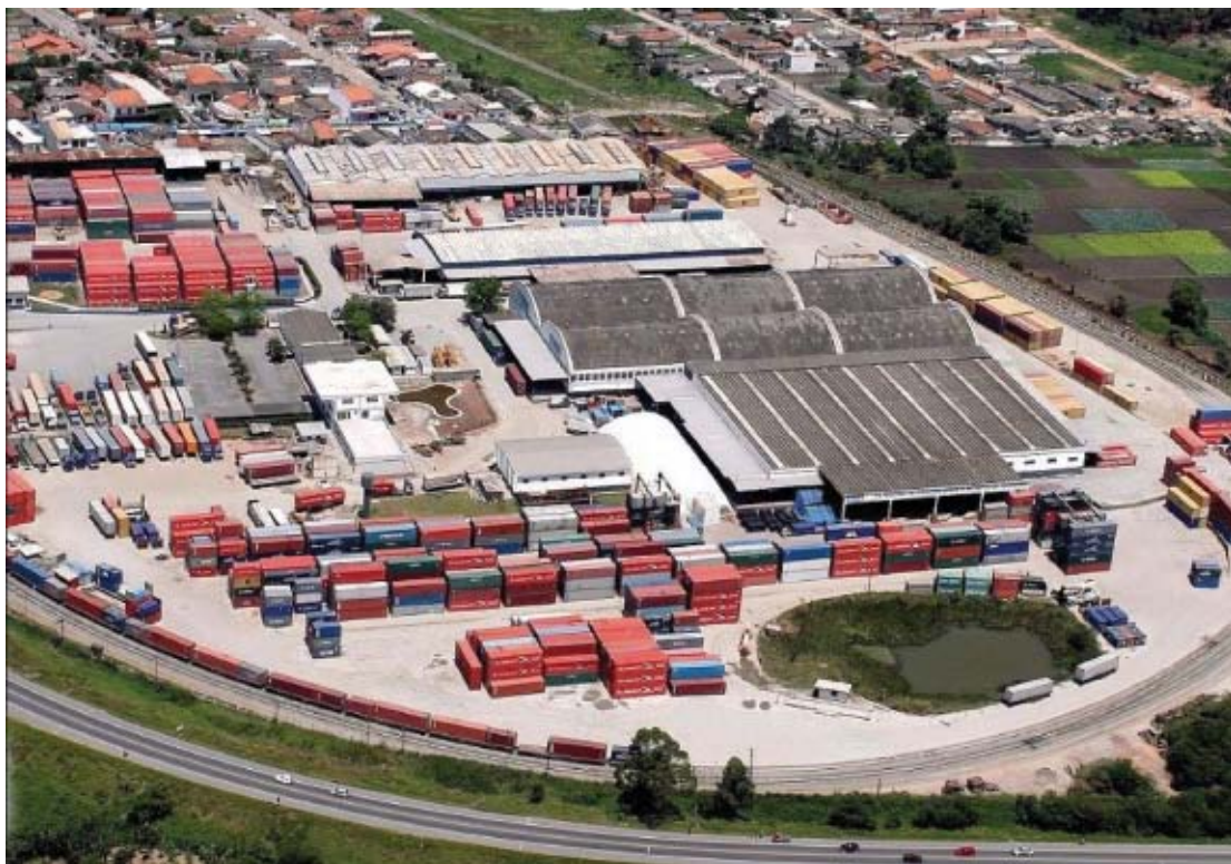
O centro de exportação de peças da Ford de Suzano está instalado no entreposto aduaneiro, numa área de 1.900 m 2 , e mantém a mesma estrutura de padrão global da Ford
