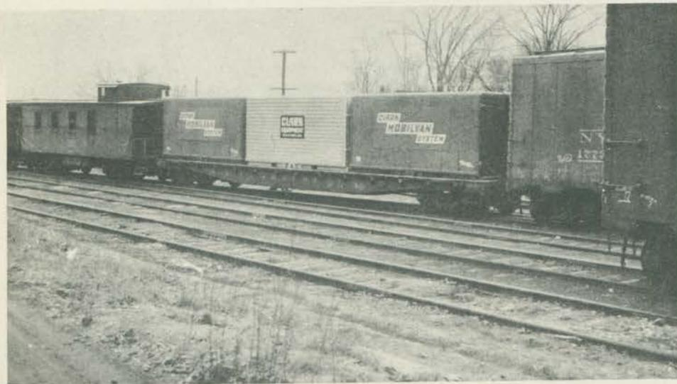
**"CONTAINERIZANDO"** — Chama-se Clark Mobilvan System. São "containers" que passam rapidamente de um vagão para um chassis de reboque, podem ser embarcados em um avião, ou guindados sem dificuldade para um navio. Não é mais novidade nos Estados Unidos ou na Europa. O processo continua, porém, sendo uma promessa de efetivação do entrosamento entre os diversos sistemas de transporte nos países onde ainda não se implantou. **Serviço de Consulta, n.º 12.**
