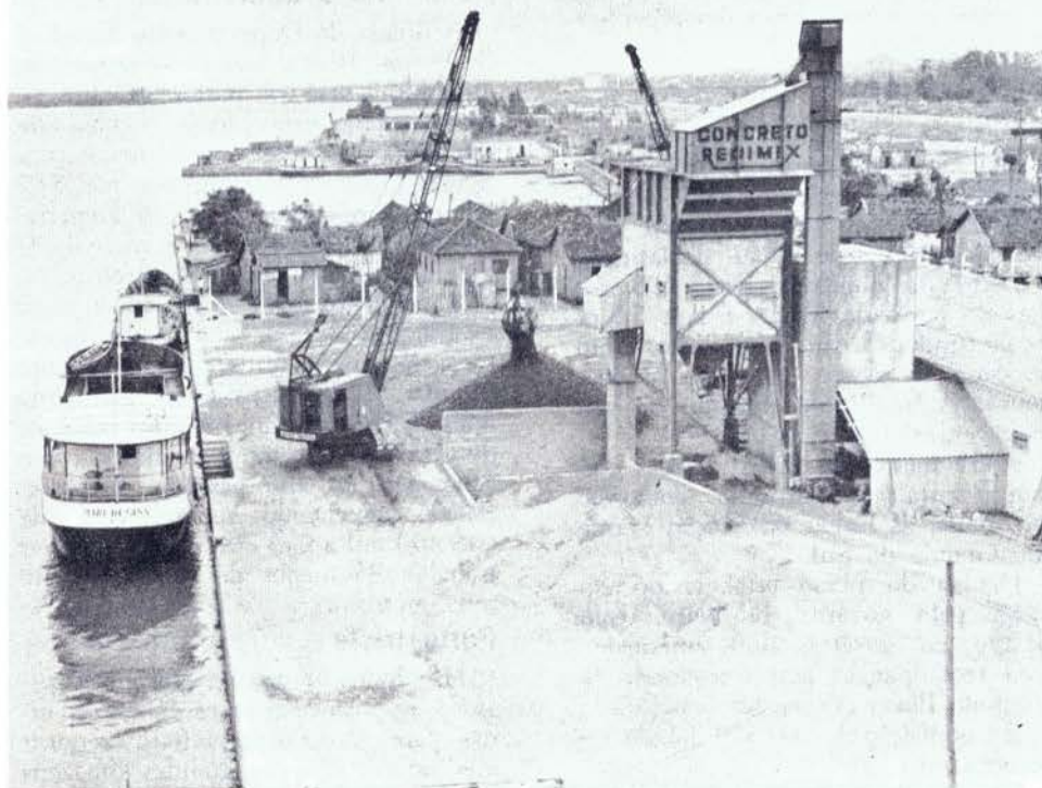
CAIS-CONCRETO — Redimix, empresa que se estende pelo País, com especialização no campo do concreto, mantém um pequeno cais onde acostam barcos que trazem pedras ou outros produtos utilizados em sua indústria. Nesse cais se trabalha.
