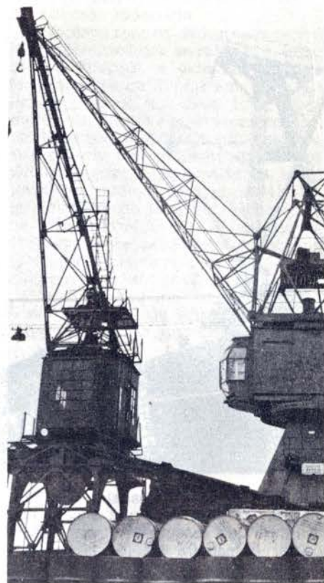
ENCOSTADOS — Guindastes antigos, perfilados ao longo do cais, estão encostados por defeituosos ou falta de carga. Mofam, ou melhor, enferrujam.
