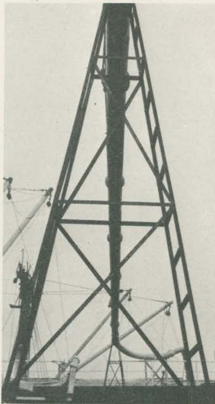
O MILHO É NOSSO — E no ano passado acumulou-se de maneira assustadora no porto de Santos, contribuindo para o congestionamento. A tubulação da foto liga diretamente o caminhão ou vagão ao navio cargueiro.
