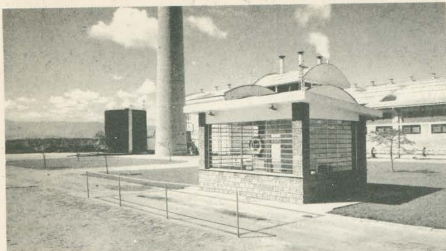
REGISTRADORA — Bem na entrada da Cia. Celulose Brasileira S.A., em Aparecida (SP), fica localizada a balança. Tudo o que entra ou sai, até o limite de 21 t, ela pesa e registra com uma fidelidade que assegura controle absoluto.
