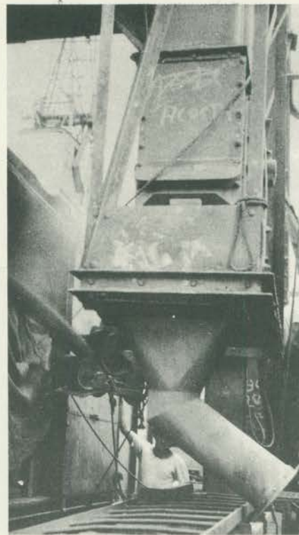
O TRIGO É DÊLES — E também se constitui numa das principais causas do congestionamento. O sugador atira o cereal pela porta do vagão-fechado, feito para mercadoria embalada e não para transporte de sólidos a granel.
