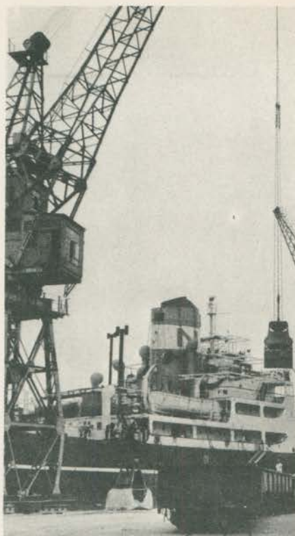
A COLHER DE CHÁ — O "grab" que se vê na foto é muito usado no porto de Santos para carga e descarga de granéis sólidos. Método tão racional quanto esvaziar uma banheira com colher de chá. Mais vagaroso talvez...
