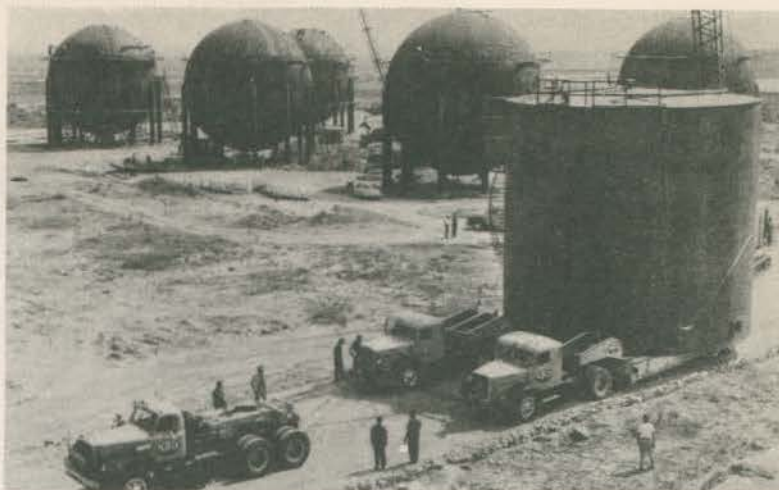
Reservatório de 12 m de altura por 10,5 m de largura - da Fábrica de Barracha Sintética - FAVOR (Transportado por conjugação de 3 cavalos mecânicos e 2 carretas).
