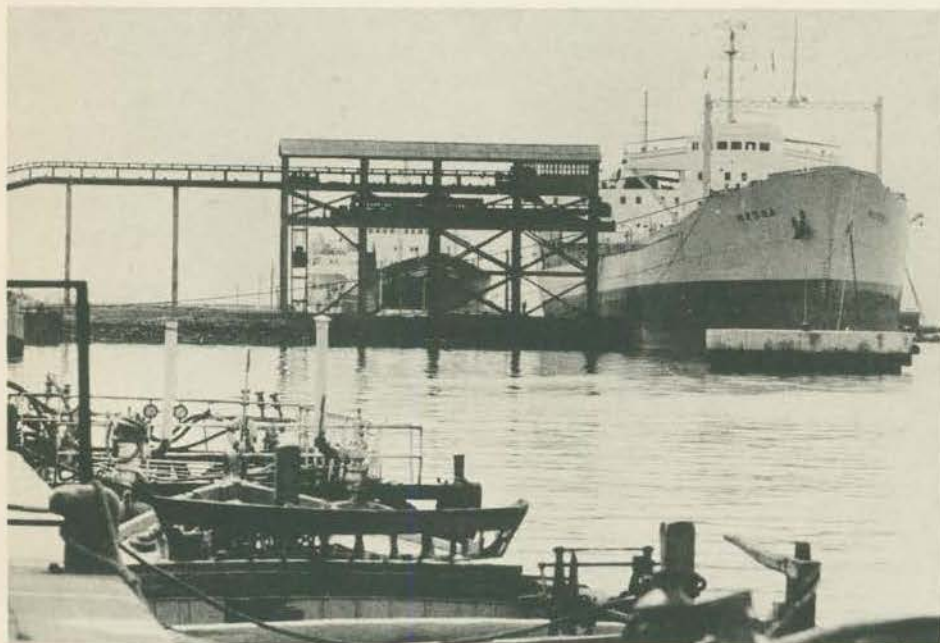
DO TREM AO NAVIO — O minério vai diretamente das margens da linha ferroviária para os porões dos navios através de um novo sistema transportador.
