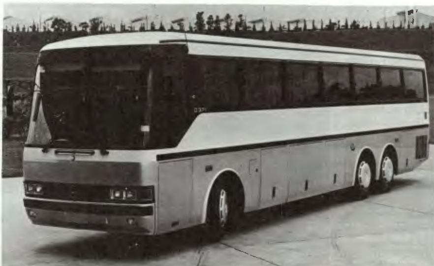
Os ônibus ganharam pára-brisa laminado, farol de neblina e pisca-pisca lateral
