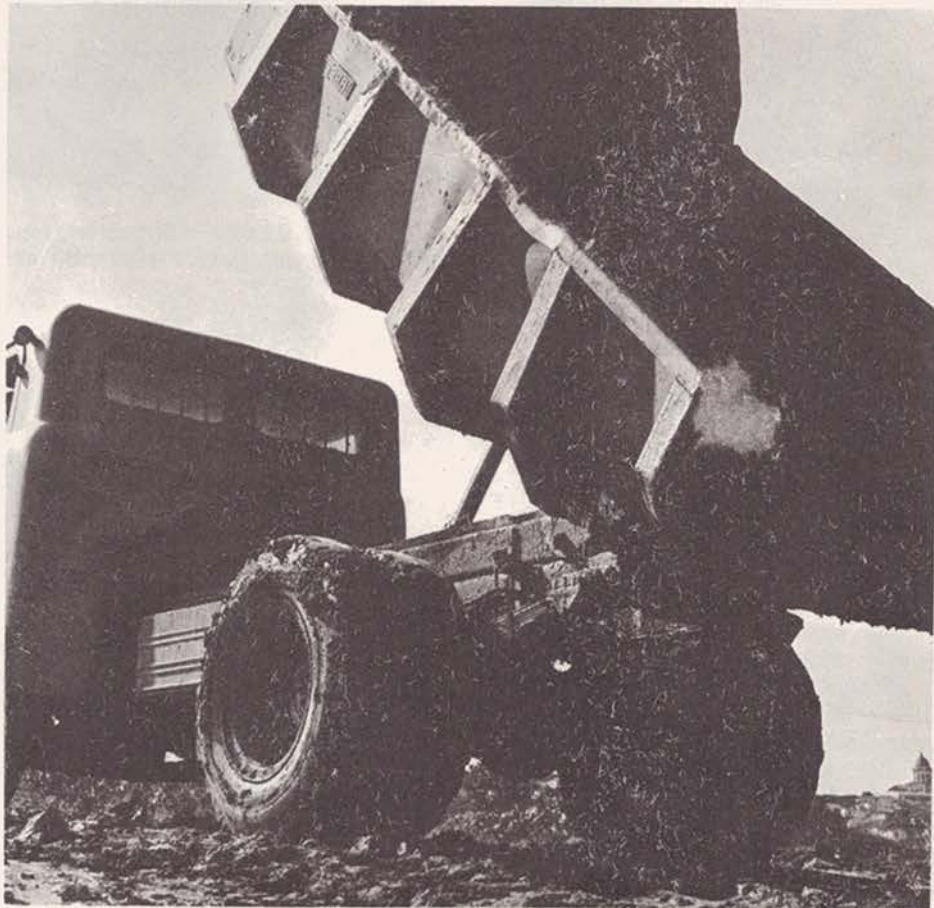
BASCULANTE DESCARREGA — Fazendo sòzinho a descarga, o basculante é muito usado no movimento de terra, areia, pedra, etc. Serviço de Consulta, n.º 21.
