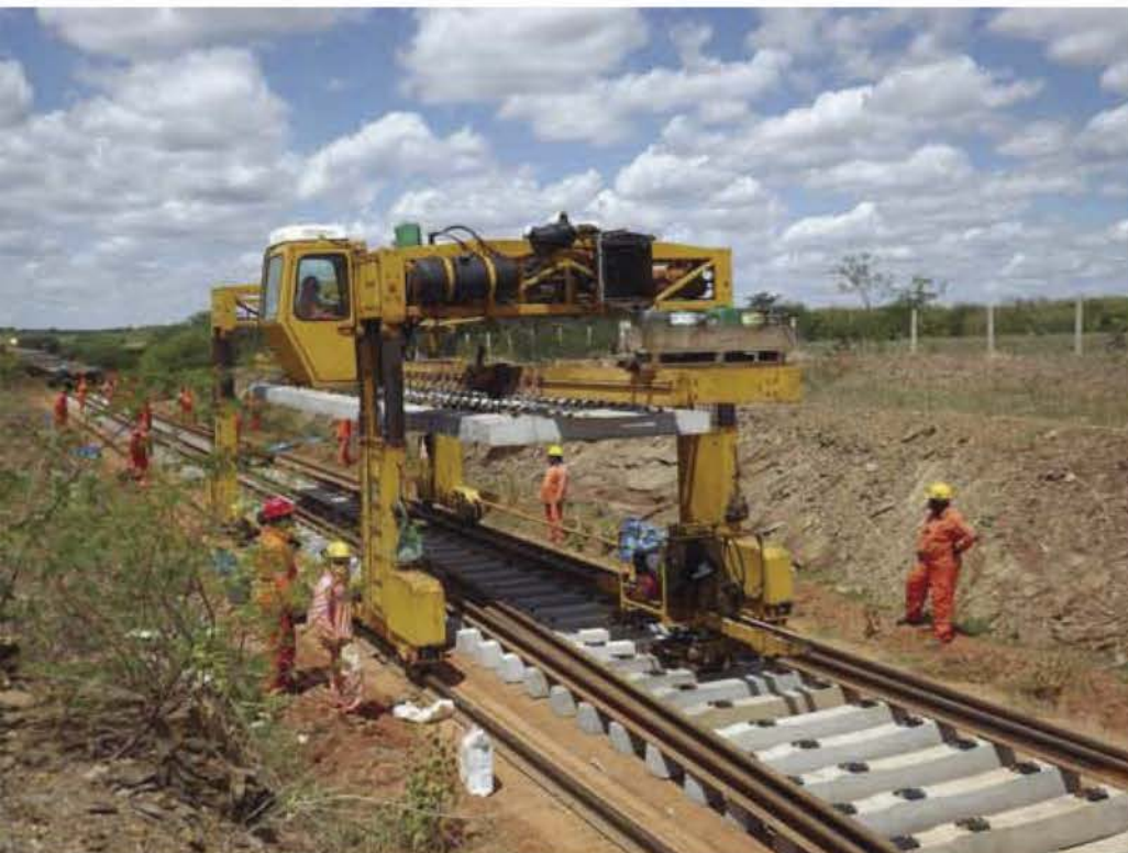
Operários trabalham na construção da ferrovia Transnordestina
