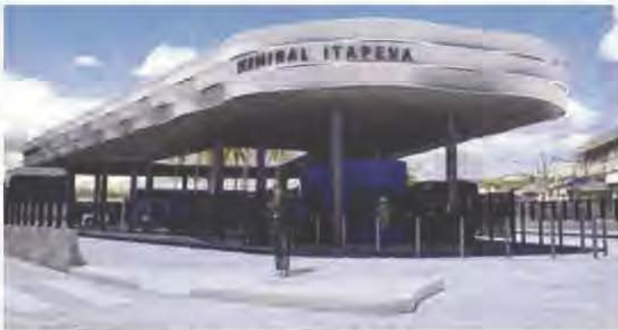
Cidade investe na construção de seis novos terminais de ônibus
