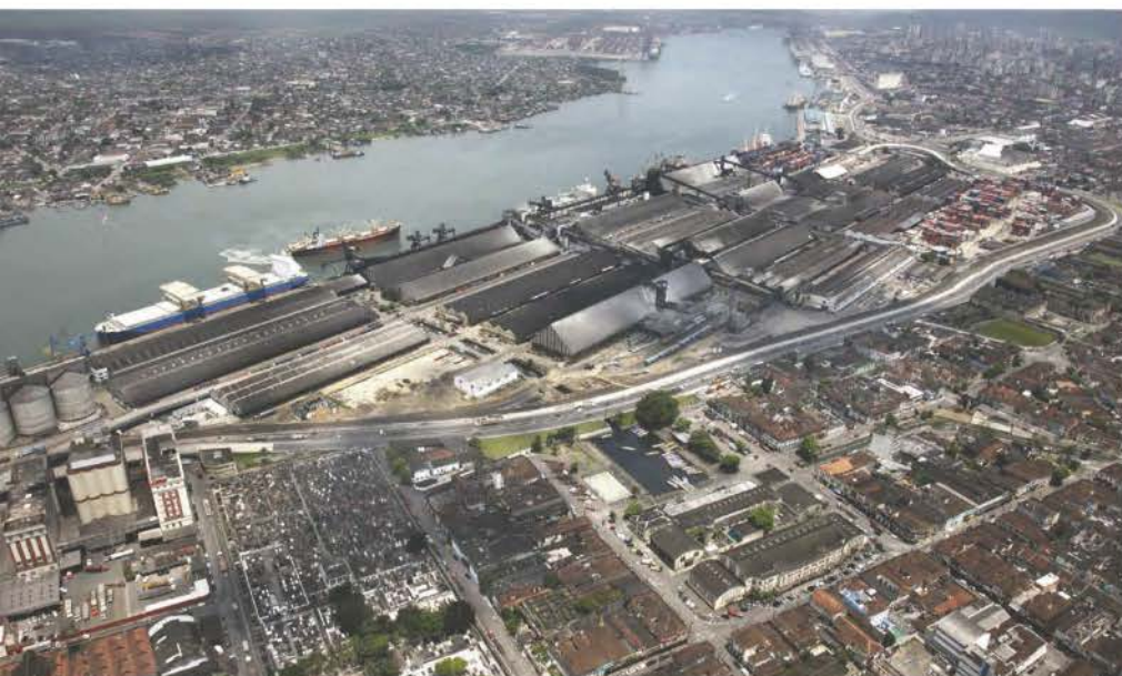
Com últimos investimentos, o porto de Santos dobrou movimentação de contêineres
