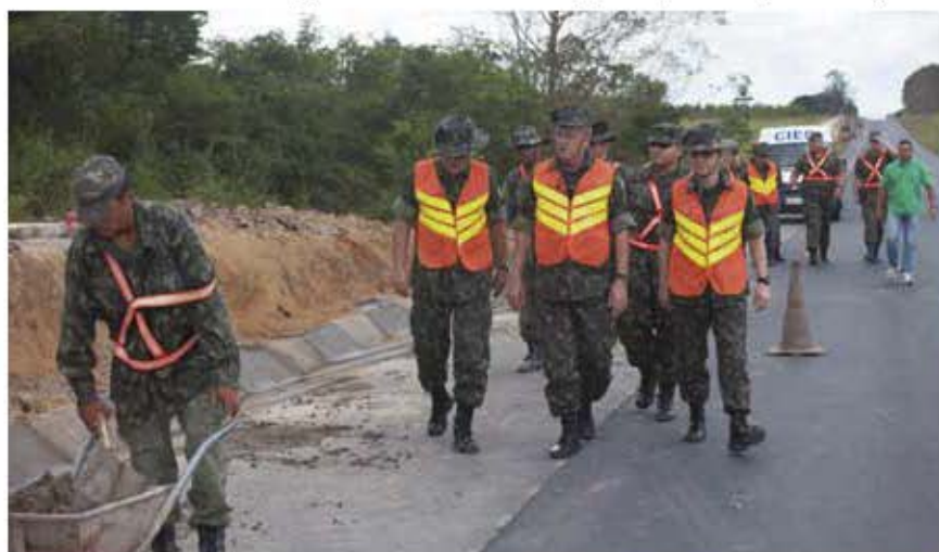
General Joaquim Brandão Jr. (no centro), chefe do DEC, inspeciona obras na BR-418BA
