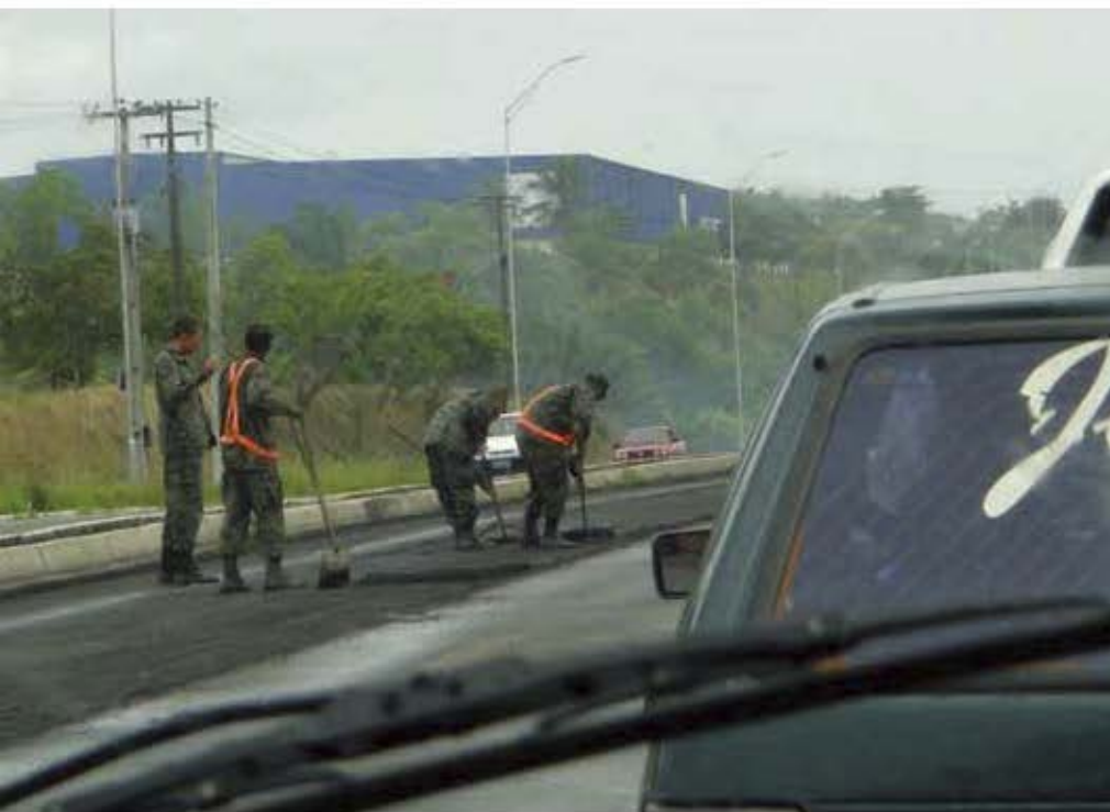
Na pavimentação da rodovia estadual SC-114, Exército atua para recuperar a estrada
