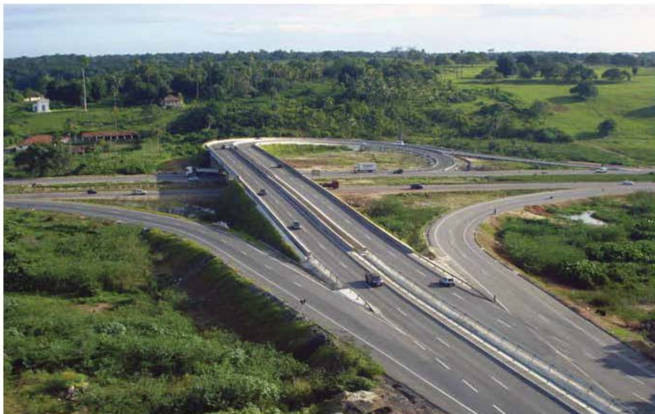
Obras de arte, como pontes e viadutos, fazem parte das funções de Engenharia e Construção do Exército Brasileiro
