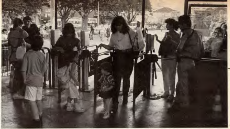
Catracas eletrônicas dão acesso ao TIC por meio de fichas eletrostáticas
